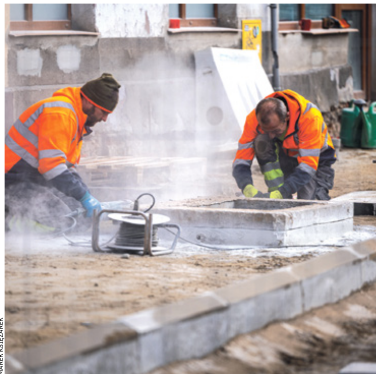
Przebudowa ulicy Pomorskiej, trwają intensywne prace naziemne
